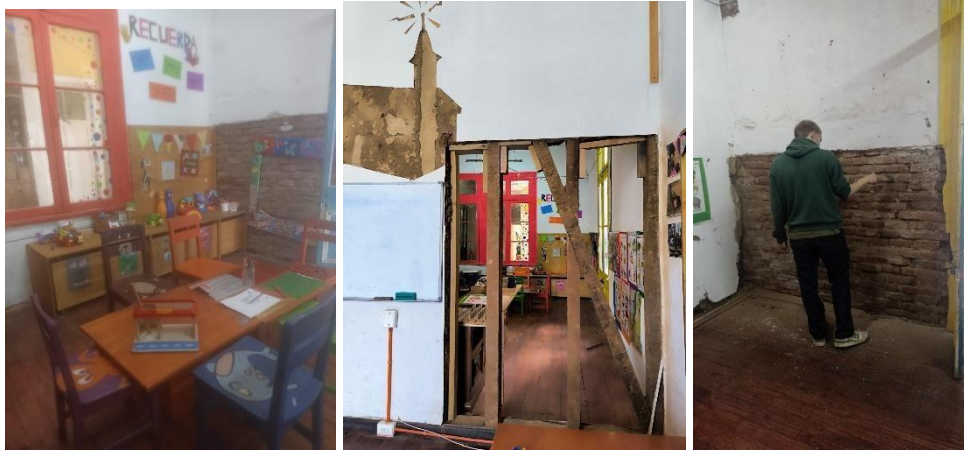
Imágenes 123,124 y 125. Apertura de muro, creación mueble y decapado sala niñez.
